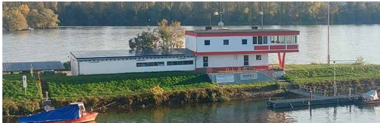
Die Wasserrettungsstation nach Abschluss der Dämmung im angepassten DLRG-Rot
